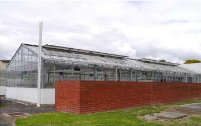
【写真：ノックスフィールド農業試験場】
